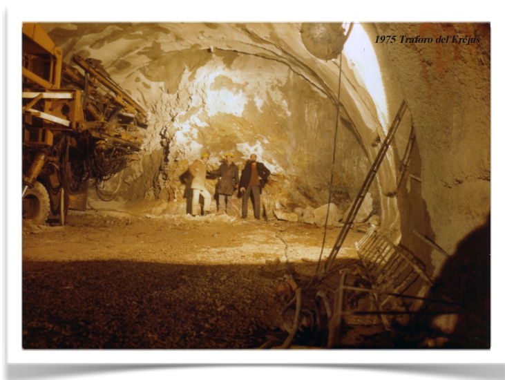
1975 Traforo del Fréjus
