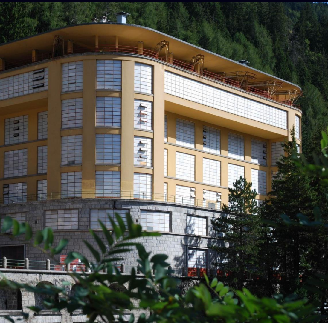
Padiglione Servizi, Sondalo, 1935
